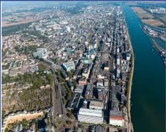
BASF Site Ludwigshafen
