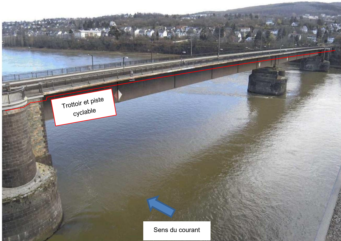
Photo du pont depuis l'amont, rive gauche
