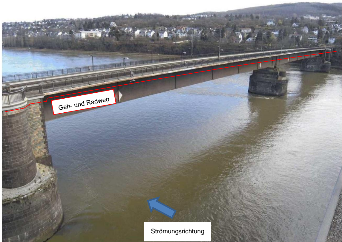
Foto der Brücke von Oberstrom, linke Uferseite
