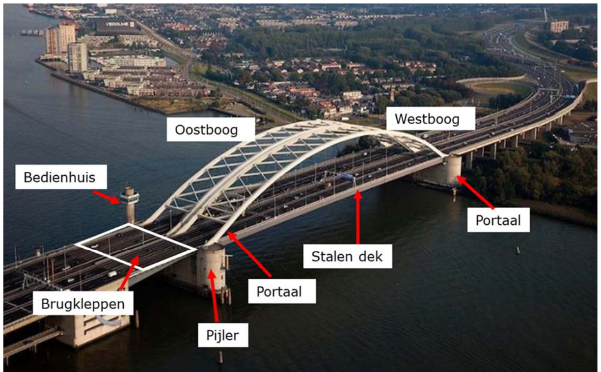
Overzicht Van Brienoordbrug
