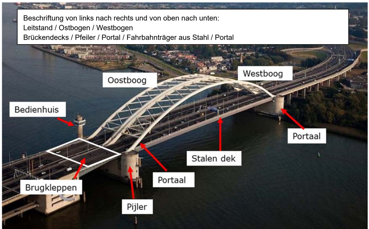
Übersicht Van Brienenoordbrücke
