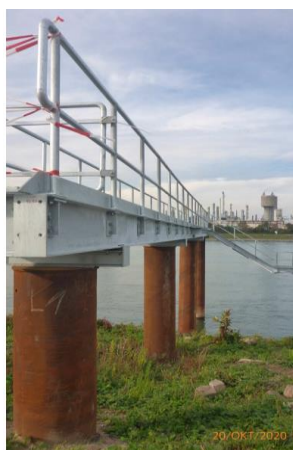
Afbeelding 6: Walsteiger bij de ligplaatslocatie Mannheim
