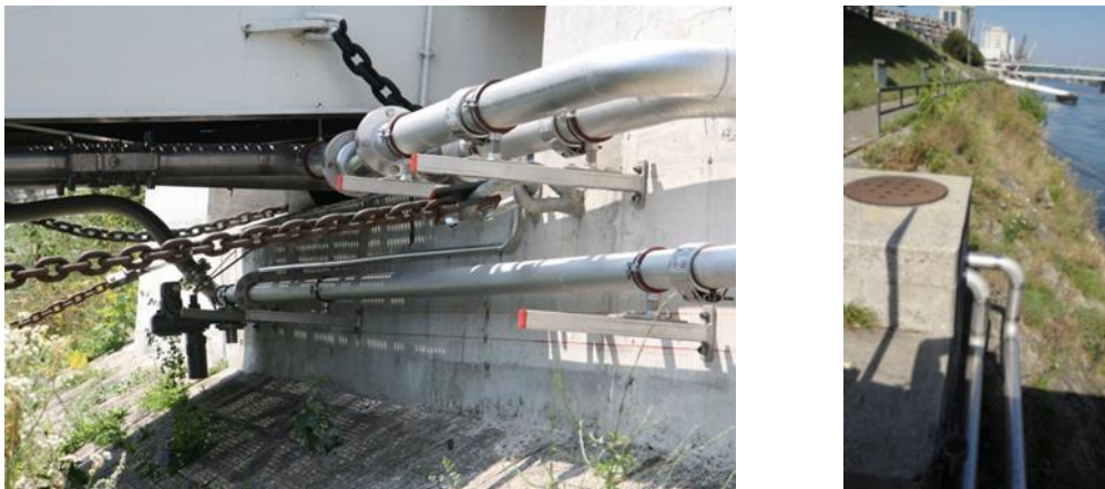
Figure 2 : puisard pour le déversement des eaux usées domestiques
