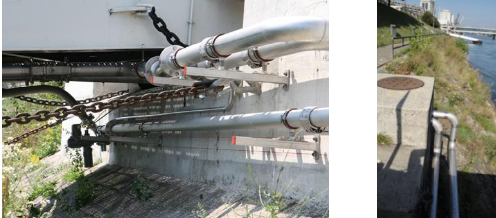
Abbildung 2-8: Einlaufschacht für Häusliche Abwässer
